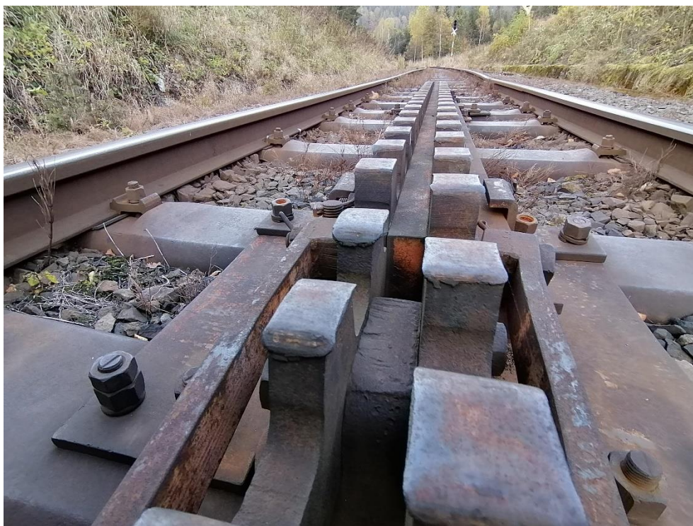
Obrázek 3 - Poškození ozubnicového nájezdu
