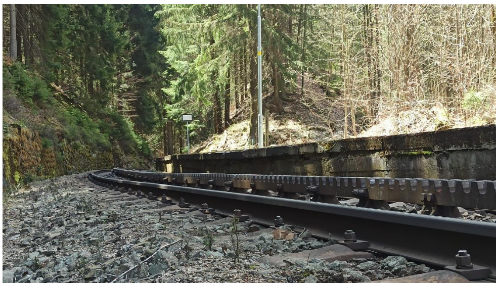
Obrázek 2 - Výškové propady ozubnicových tyčí
